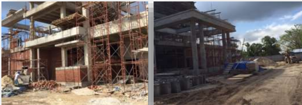
Kerja-kerja pembinaan Mahkamah Baharu Besut, Terengganu.
